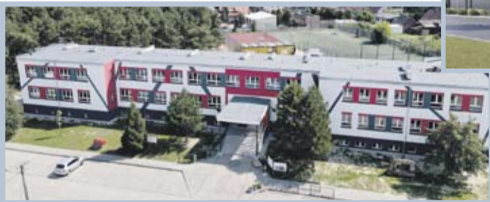
Termomodernizacja szkoły w Kopanicy
