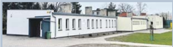
Termomodernizacja szkoły w Chobienicach
