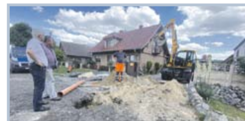
Budowa kanalizacji Reklin - Reklinek
