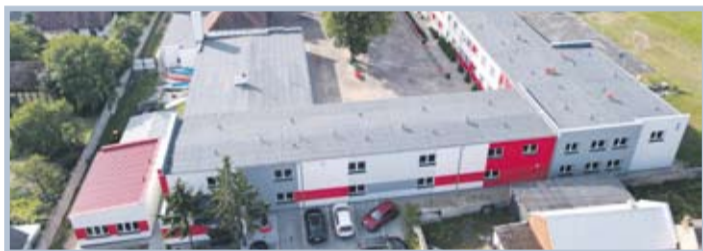
Termomodernizacja szkoły w Siedlcu
