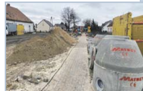
Budowa kanalizacji w Belęcín
